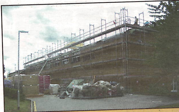
V polovině června se na zateplení pláště stochovské sportovní haly již pilně pracovalo.
